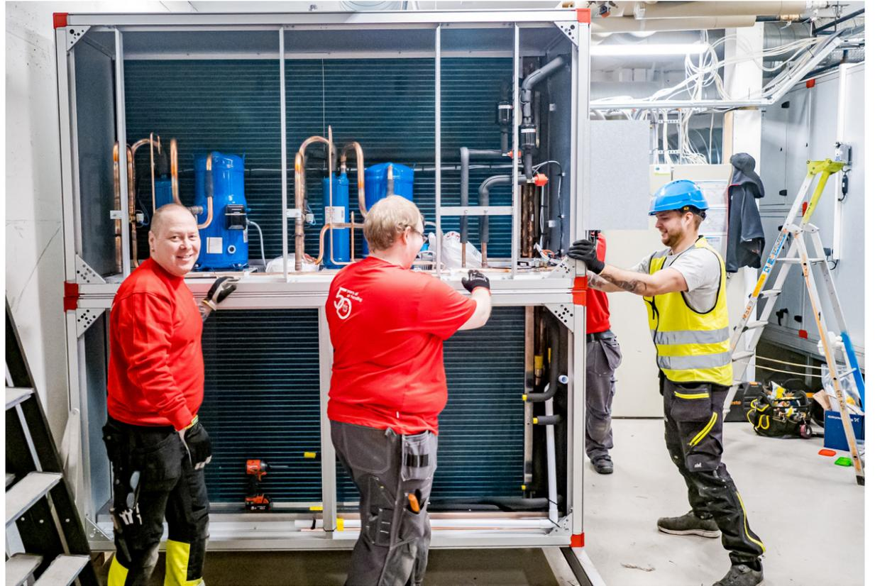
Die zerlegbare, integrierte, reversible Wärmepumpe ThermoCooler HP wird aufgestellt.
