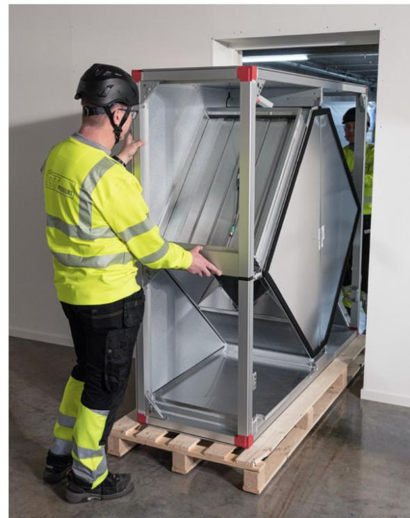
Der geteilte Gegenstromwärmetauscher wird durch eine 90 cm breite Türöffnung transportiert.
