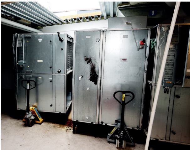
Vuoden 1991 koneen lämmön talteenottoaste oli noin 40 %. Puhaltimien SFP-luku oli 3 kW/m³/s.
