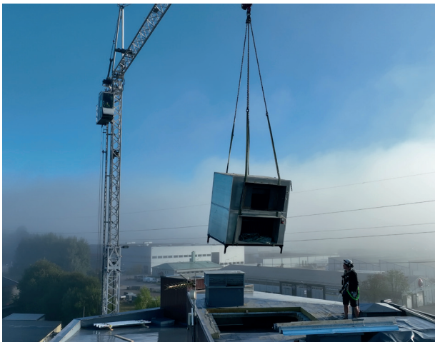
Katon avaaminen, olemassa olevan ilmastointikoneen nostaminen pois ja uuden asentaminen kesti noin viikon.
