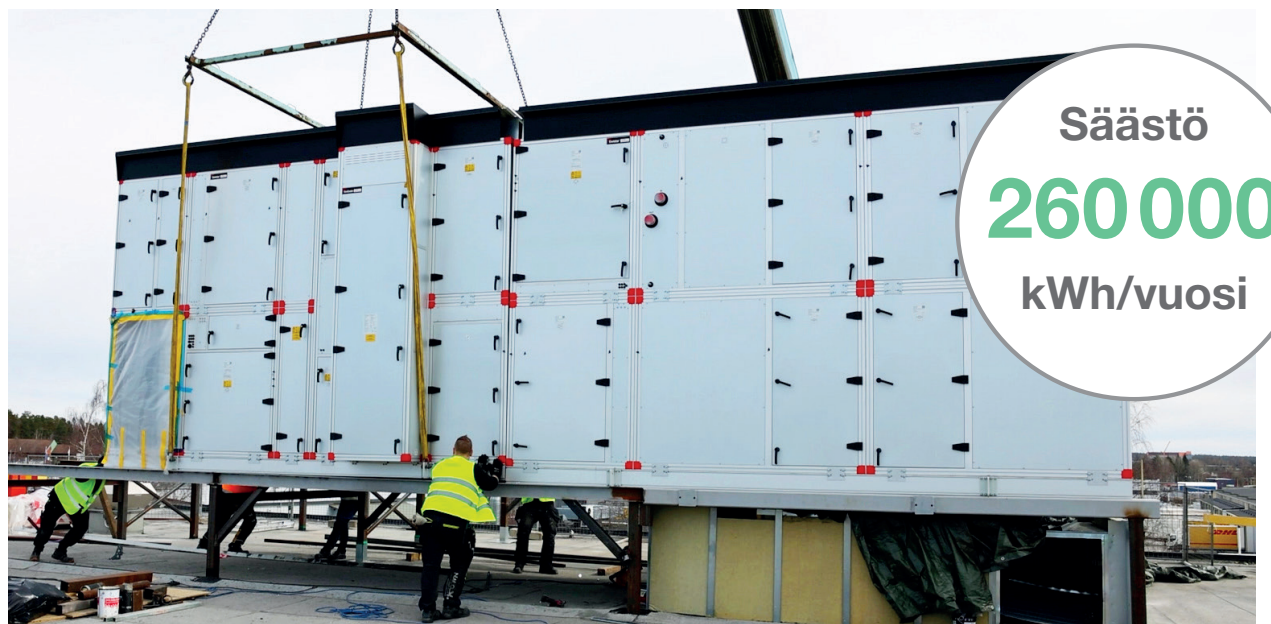
Envistar Flex, koko 1280, varustettuna integroidulla EcoCoolerilla ja jäähdytyksen talteenotolla.
