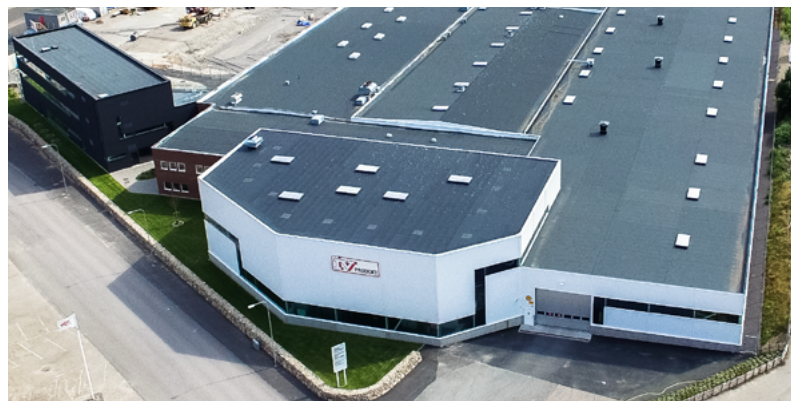
Biuro projektowe, fabryka i centrala w Växjö.
