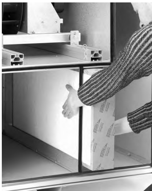
Byte av filter
