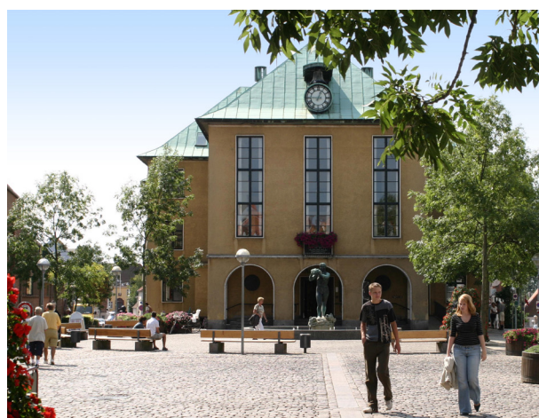
Da die Kühlung bereits in die Lüftungsgeräte integriert ist, konnte die historische Architektur des Rathauses von Sønderborg bewahrt werden.
