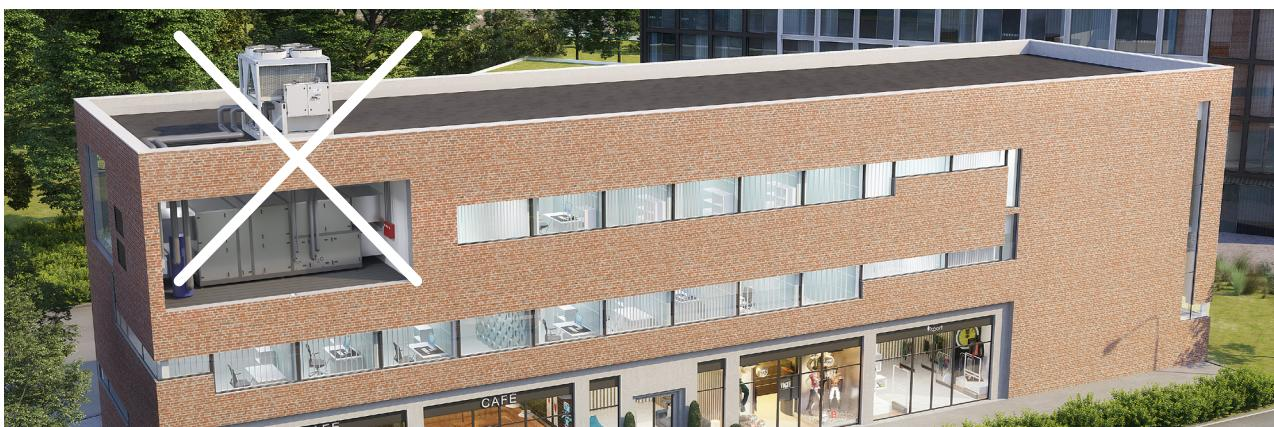
Et gavtilsluttet anlæg kræver et teknikrum på 30 m<sup>2</sup>, mens det tilsvarende areal for de tre toptilsluttede anlæg er blot 10 m<sup>2</sup>.
