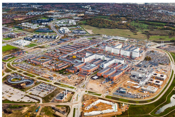
Nord-Europas største sykehus Aarhus universitetssykehus, Skejby, Danmark
