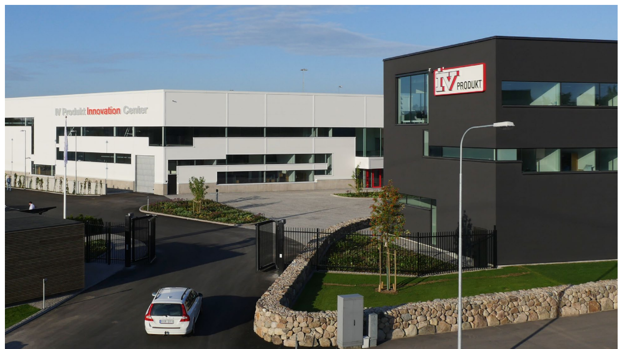
Vuonna 2016 käyttöön otettu IV Produkt Innovation Center. Viiden vuoden aikana 200 miljoonan kruunun investoinneilla on saavutettu alan uudenaikaisin testilaboratorio, suuret koulutustilat, toimistotiloja sekä laajennetut tuotantotilat moderneine levykäsittelylinjoineen.
