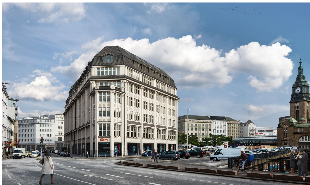
Den statelige bygning Bieberhaus i Hamburg ventileres ved hjælp af otte Envistar Top-aggregater fra IV Produkt.
