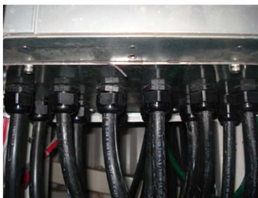
Kuva 5.14: Esimerkki läpivientilevyn asianmukaisesta asentamisesta.
