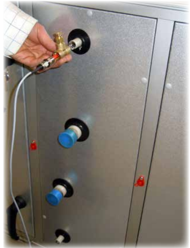
Размещение погружного датчика, ПВ слева
