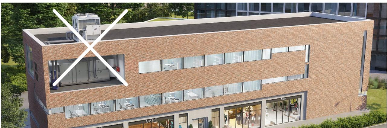
Ein seitlich angeschlossenes Gerät benötigt eine rund 30 m<sup>2</sup> große Lüftungszentrale, während drei Top-Geräte lediglich circa 10 m<sup>2</sup> Fläche insgesamt benötigen.
