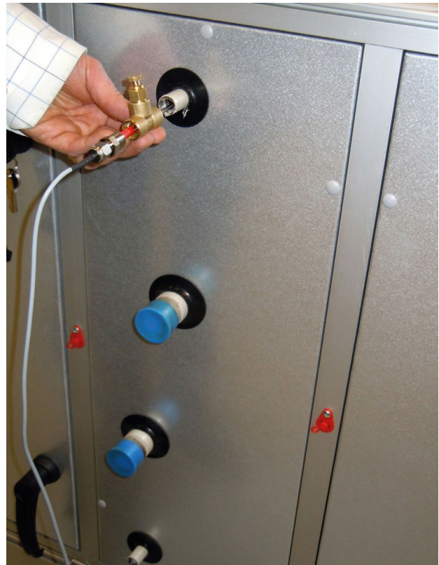
Jäätymissuoja-anturin ja ilmanpoistonipan sijainti, tuloilma vasemmalle
