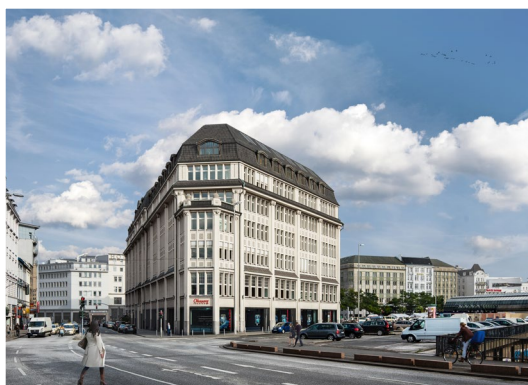
Bieberhaus i Hamburg, Tyskland
