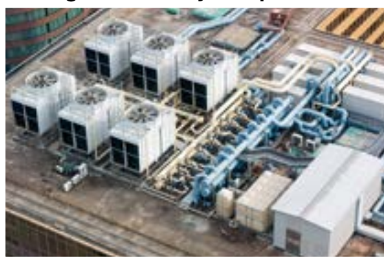
Ingen installasjoner på taket
