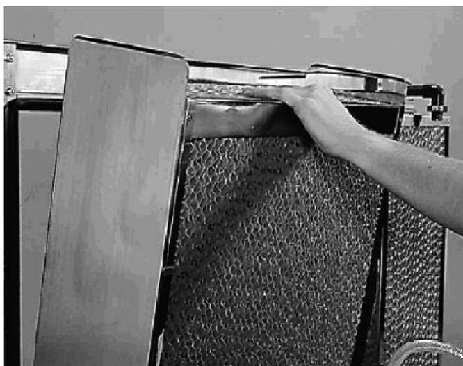
С кассетами увлажнителя следует обращаться с большой осторожностью, чтобы не повредить материал GLASdek. Вставлять, извлекать и поднимать кассеты всегда следует только за металлическую обейчайку.
