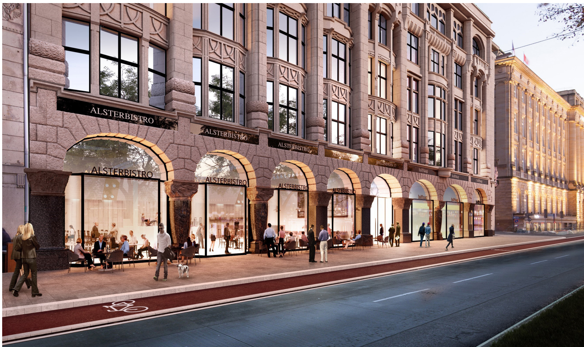
Et behageligt indeklima sikres af ca. 30 ventilationsanlæg fra IV Produkts Envistar-serie i den prestigefyldte bygning på Ballindamm 17 i Hamborg. Foto: QUEST Investment Partners
