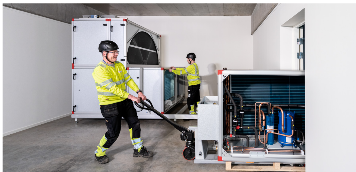
Pär och Ola fra IV Produkt fører en Envistar Flex-anlæg i størrelse 600 med den integrerede køle-/varmepumpe ThermoCooler HP gennem en dør i standardstørrelse.
