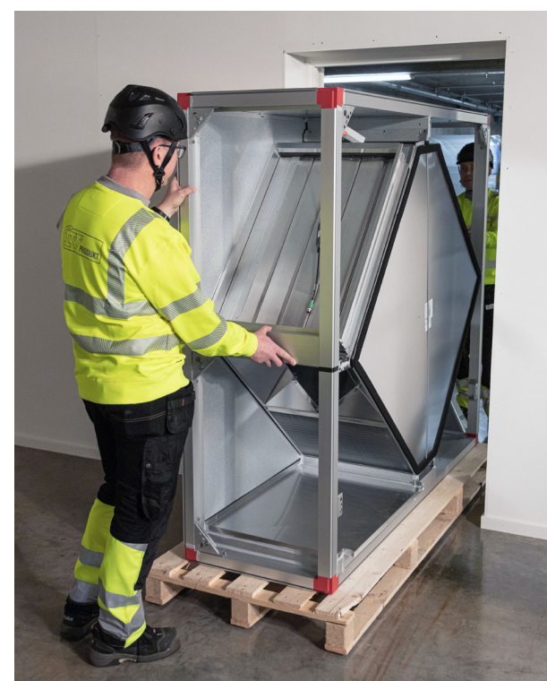
Den opdelte modstrømsvarmeveksler føres gennem en 90 cm bred døråbning.
