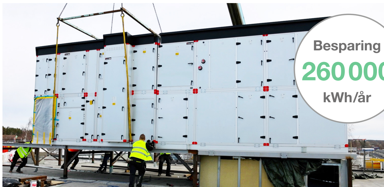
Aggregaten är Envistar Flex i storlek 1280. Med det integrerade kylaggregatet EcoCooler med kylåtervinning klarar de ett luftflöde på cirka 9 m 3 /s vardera.
