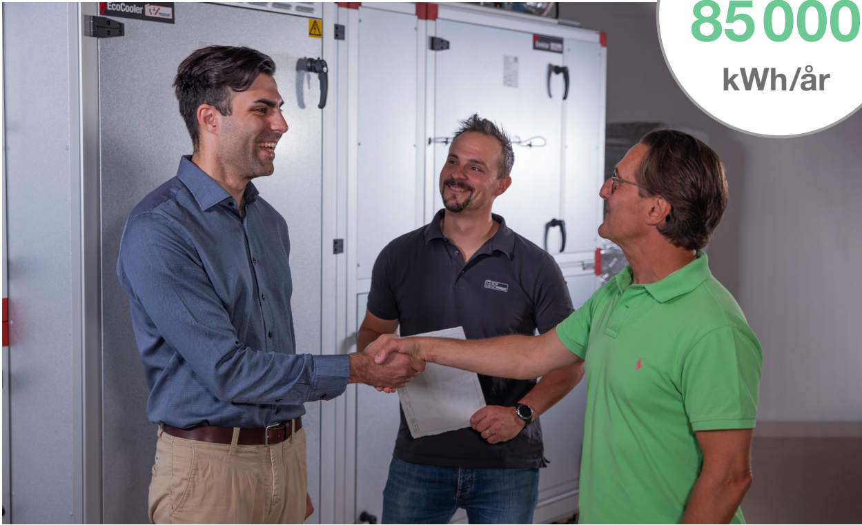
Fastighetsägaren, installatören och IV Produkts säljare vid det nya aggregatet. Den höga värmeåtervinningen gör att tillsatsvärmen från fjärrvärme sänktes med cirka 80 %. Elanvändningen till fläktarna sjönk med cirka 50 %.
