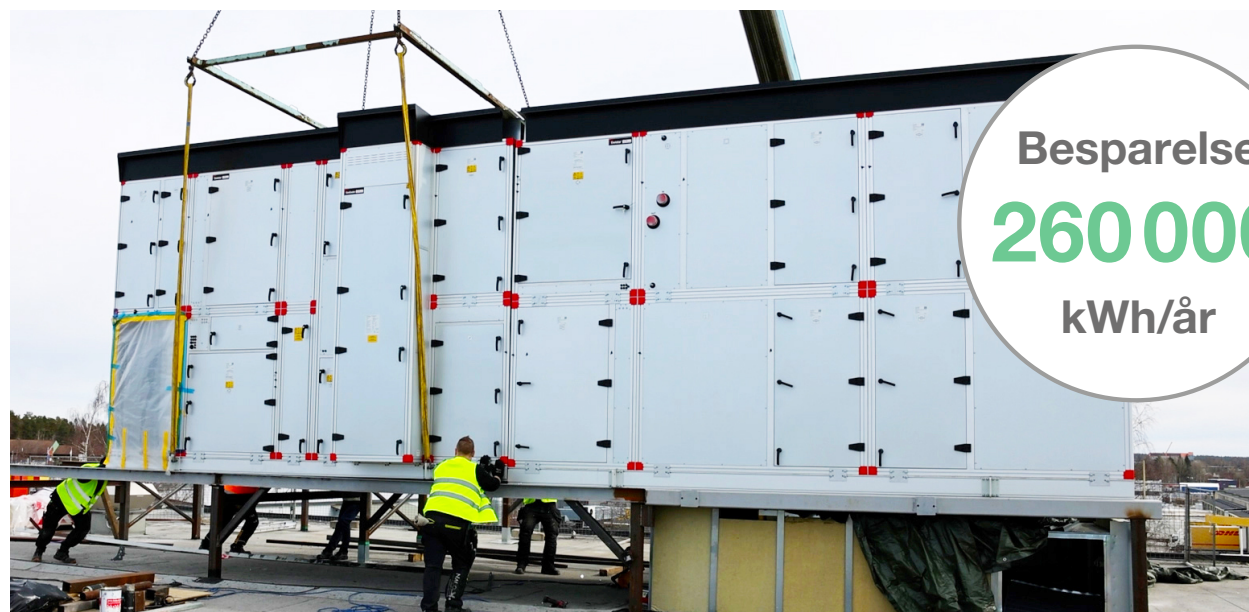
Aggregatene er Envistar Flex i størrelse 1280. Med det integrerte kjøleaggregatet EcoCooler med kjølegjenvinning klarer de en luftmengde på cirka 32 400 m 3 /h hver.
