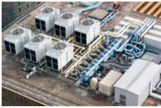
Ei asennuksia katolle
