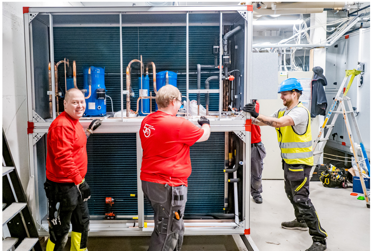
Jaettava, integroitu jäähdytys-/lämpöpumppu ThermoCooler HP asennetaan paikalleen.
