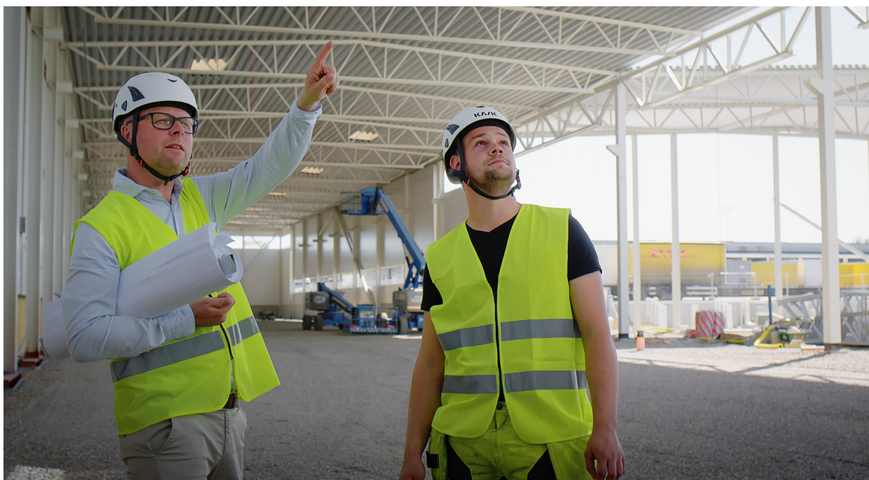
Mattias IV Produktilta katsoo eteenpäin ja uskoo vahvasti, että energiansäästö ja hyvä sisäilmasto ovat tärkeitä tekijöitä kestäväälle kehitykselle, ja uskaltaa siksi investoida ja panostaa entistä enemmän tulevaisuuteen.
