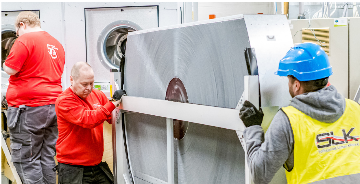
IV Produktin ja Solheim og Larsen Klima AS:n työntekijät auttavat jaetun pyörivän lämmöntalteenottokiekon sisäänkuljetuksessa.
