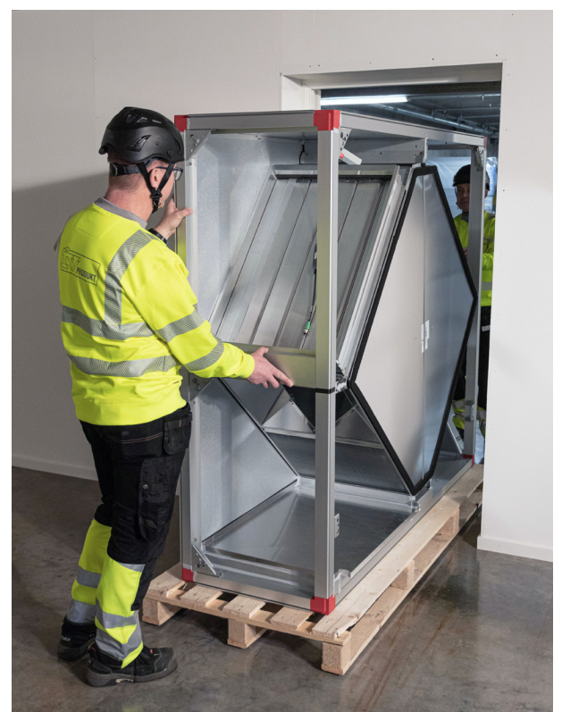
Jaettu vastavirtalämmönsiirrin kuljetetaan sisään 90 cm leveän oviaukon kautta.
