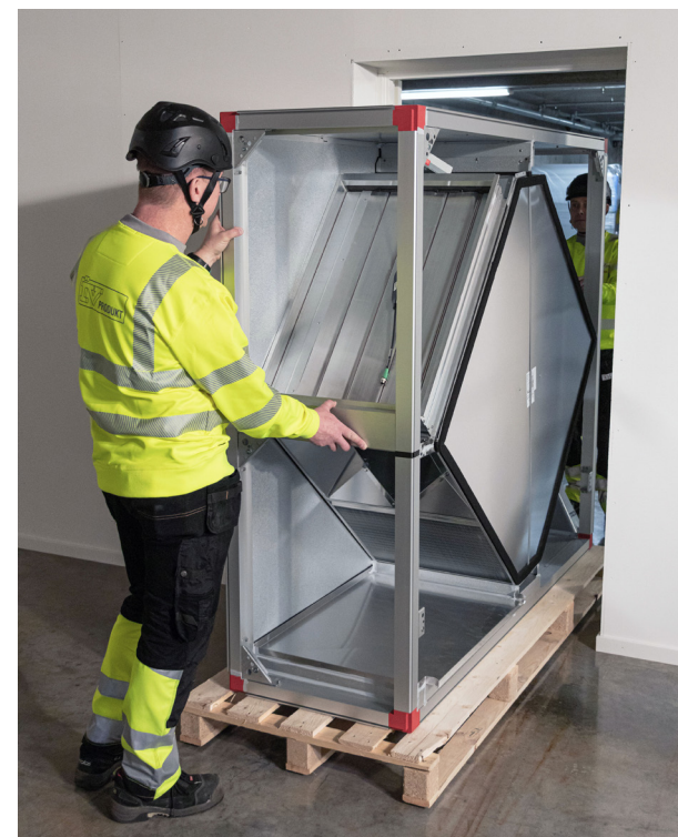
Den delte motstrømsvarmeveksleren transporteres inn gjennom en 90 cm bred døråpning.
