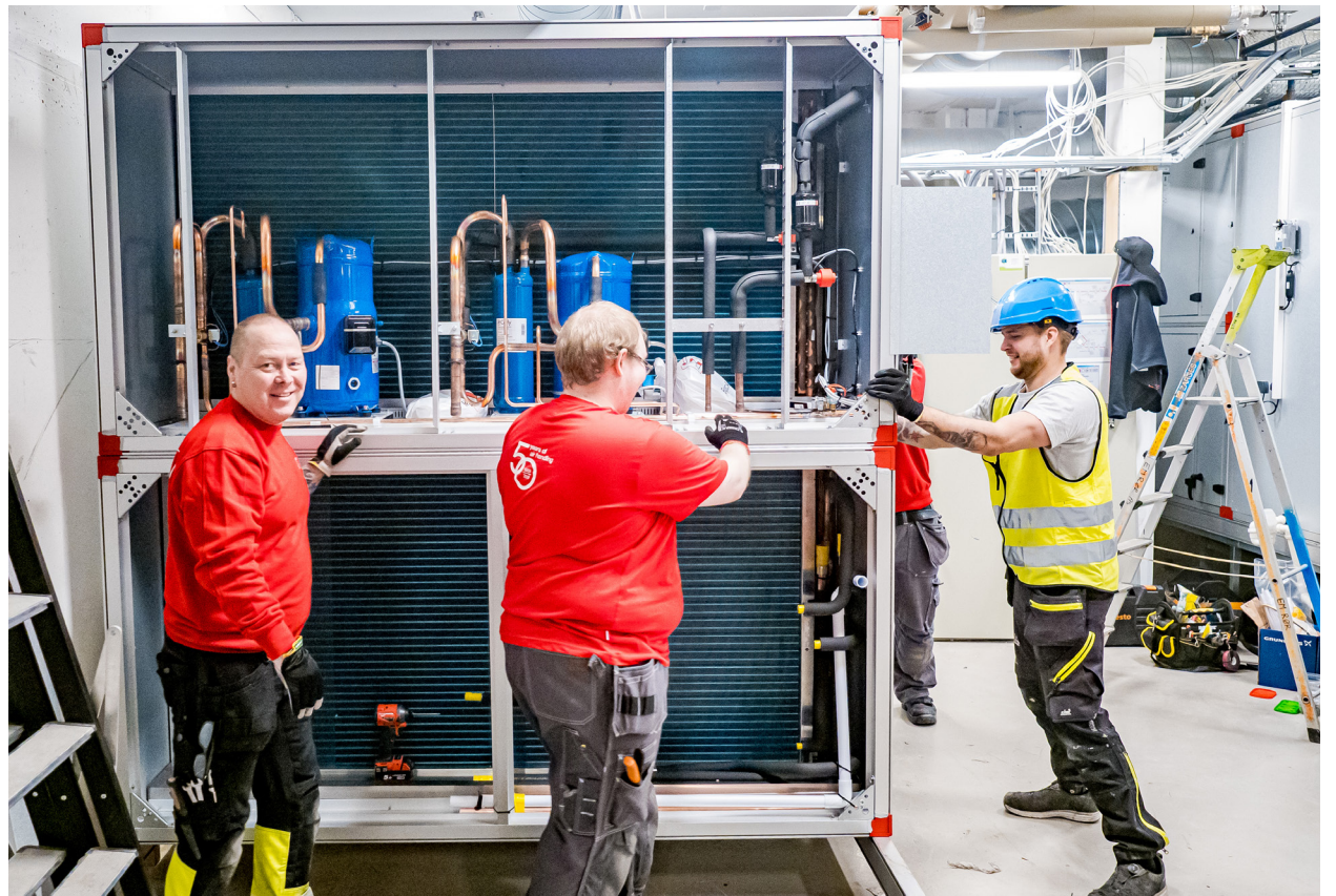
Den delbare og integrerte reversible varmepumpen ThermoCooler HP plasseres.
