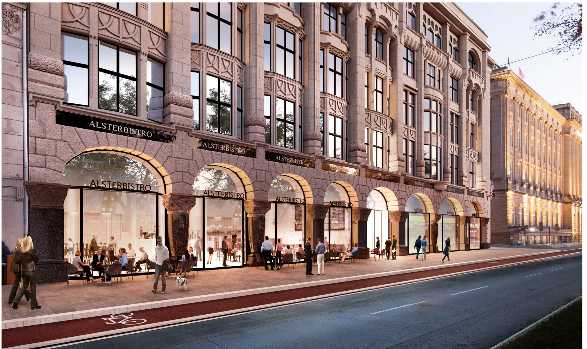
Et behagelig inn klima sikres av et trettittalls aggregater fra IV Produkts Envistar-serie i den prestisjetunge bygningen på Ballindamm 17 i Hamburg. Foto: QUEST Investment Partners
