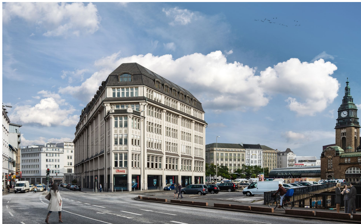
Den storslagne bygningen Bieberhaus i Hamburg ventileres ved hjelp av åtte Envistar Top-aggregater fra IV Produkt.
