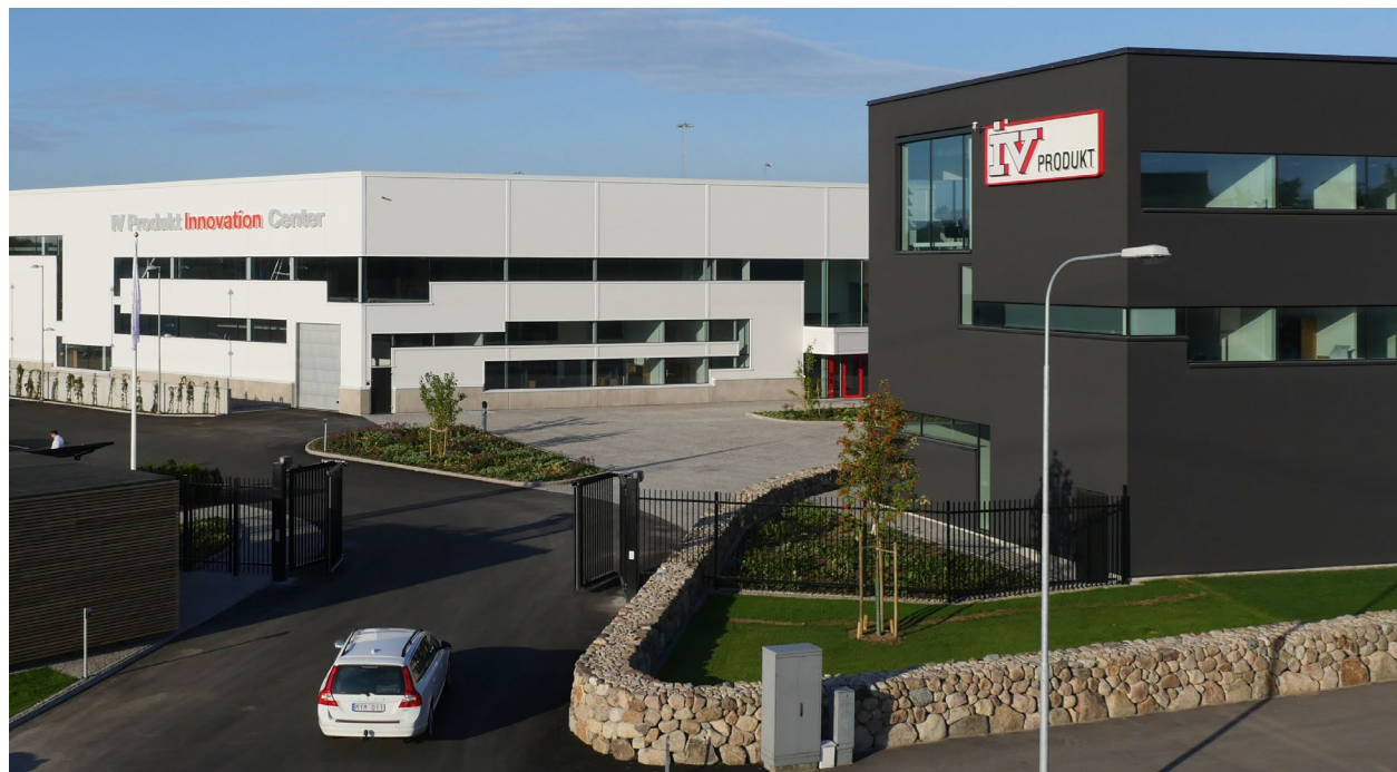
I 2016 innvies IV Produkt Innovation Center. Investeringer på 200 millioner over en femårsperiode har blant annet resultert i bransjens mest moderne testlaboratorium, store kurslokaler, flere kontorer og økt produksjon med moderne platebearbeidingslinjer.
