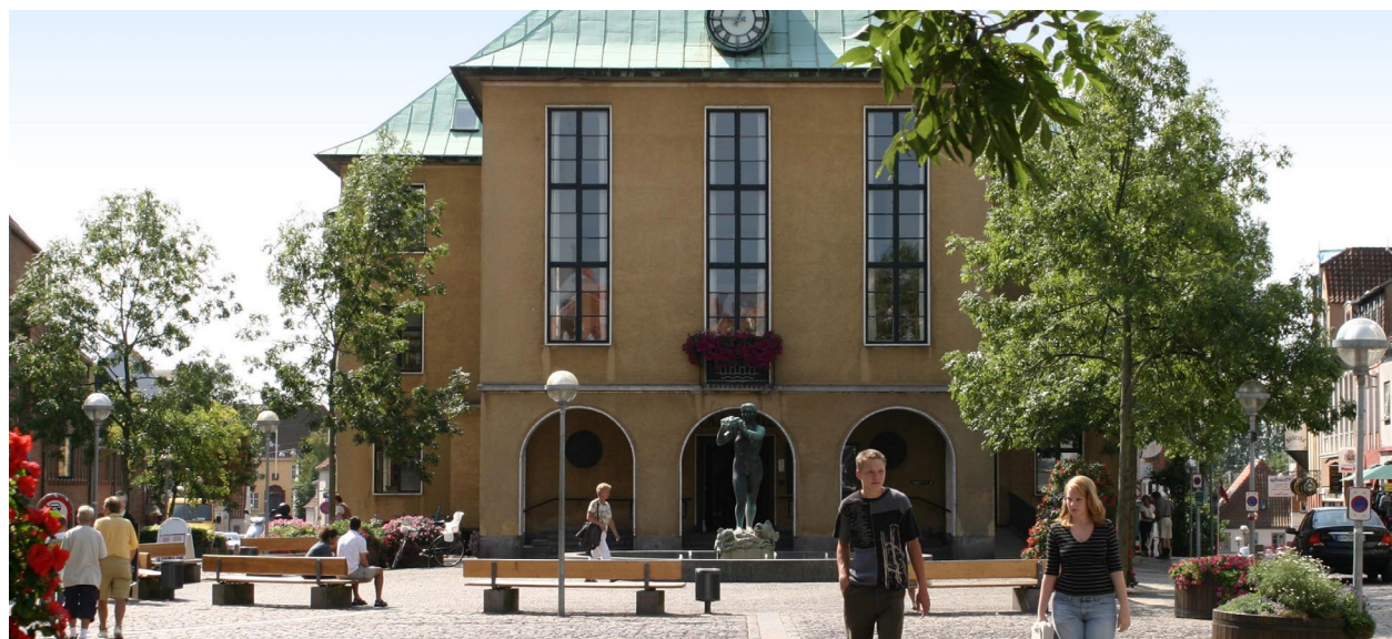
Takket være integrert kjøling i ventilasjonsaggregatene kunne rådhuset i Sønderborg beholde sin vakre arkitektur.
